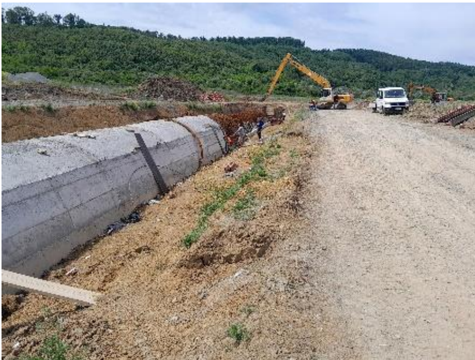
Slika 11. Radovi na izgradnji temeljnog ispusta brane retencije Glogovica, općina Podcrkavlje
