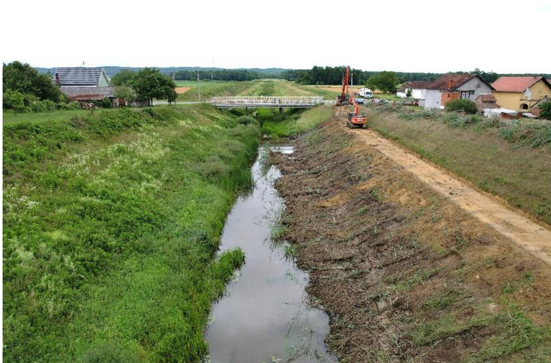
Slika 6. Iskop bermi uz ZLK Biđ polja, općina Garčin
