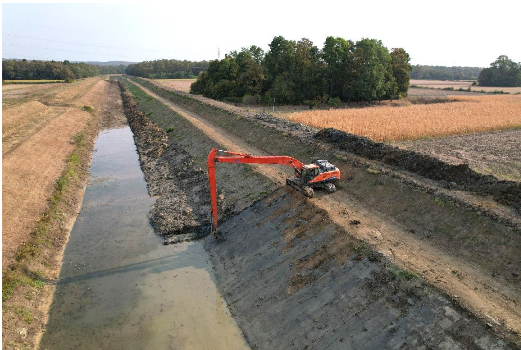
Slika 5. Uklanjanje nanosa iz korita ZLK Biđ polja, općina Garčin
