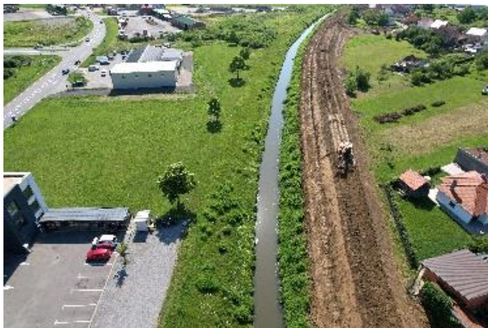
Slika 7. Iskop bermi uz ILK Jelas polja, grad Slavonski Brod
